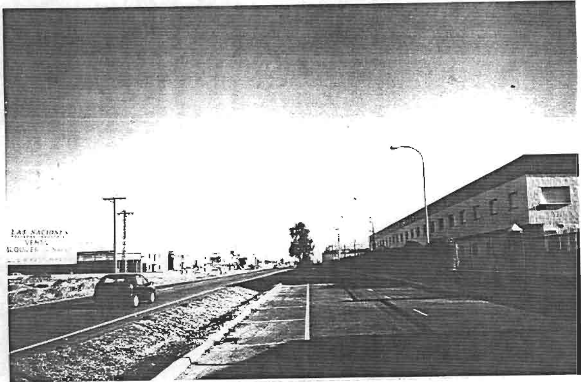
Vista de las instalaciones en sentido Humanes de Madrid
