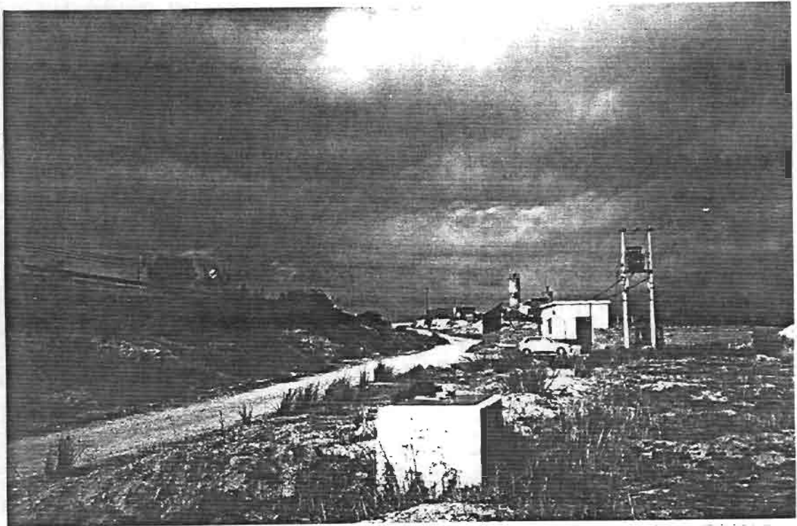
El pozo muestreado, el depósito y la planta de hormigón
